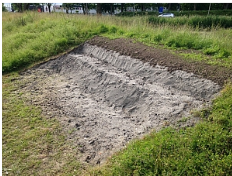
Afbeelding 4-2 Opbouw talud: vrijkomende grond en hierop zand aanbrengen (foto Menno Reemer). Vervolgens weer afdekken met vrijkomende grond.
